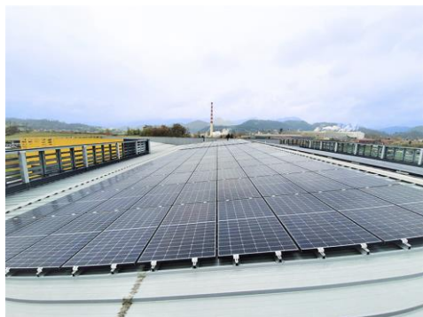
SONČNE ELEKTRARNE NA STREHAH POŠT
